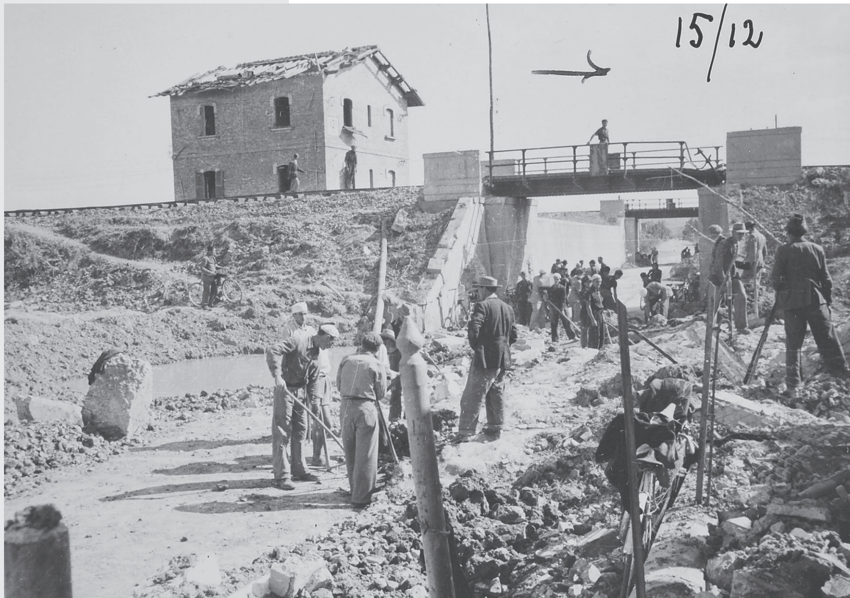
Angelo Moretti, Uomini al lavoro per la rimozione delle macerie in via Carlo Zavagli, 1944-1945 (BGR, AF/Album Moretti)
